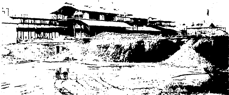
F.119- Fundidora de la familia Guggenheim en Aguascalientes
