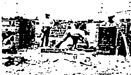
Cimentación de casas construidas en serie, empleando losas.
