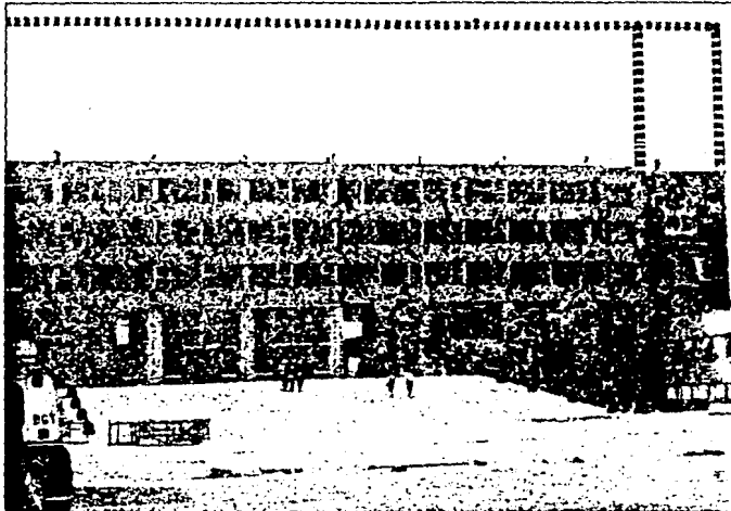
FIGURA 3. VISTA LATERAL DEL CUERPO "B" DESPUES DE LA DEMOLICION DE SUS NIVELES SUPERIORES. (ref 14)
