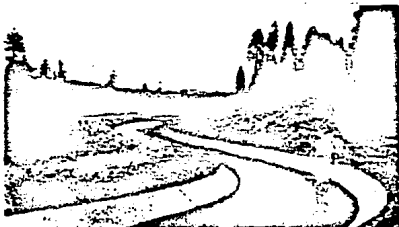
FOTO. III-2.- Canal con curvas suaves, revestido en concreto y con taludes tendidos, hecho con máquina revestidora.
