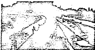
FOTO. III-8.- Canal revestido con aplanado de cemento con aditivos colocado directamente sobre la superficie dejada por la excavación. Con hierbas que crecen en las grietas y arena suelta depositada en el fondo.
