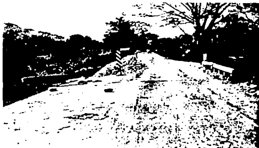
FOTO No. 1.- VISTA HACIA LA ZONA DE CRUCE DESDE LA MARGEN DERECHA, OBSERSE LA ZONA EROSIONADA POR LA CORRIENTE.
