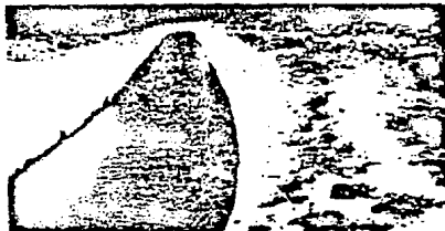
FOTO. III-6.- Canal revestido en concreto, excavado en roca volcánica, muy profundo con taludes casi verticales, muy rugoso.
