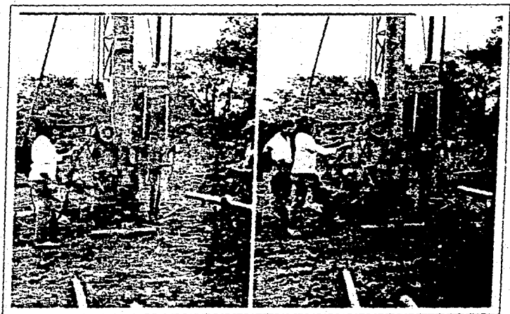
Fotografías 5 y 6. De izquierda a derecha, inicio de la prueba de penetración estándar y el transcurso de la misma
