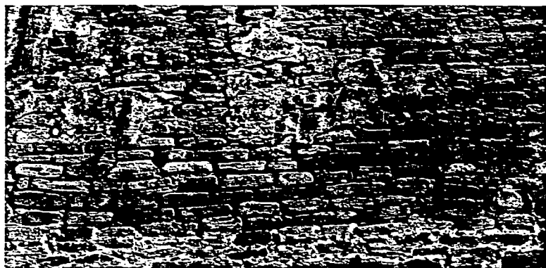
Fig. 25. Muros del templo parroquial de Azcapotzalco, en los que comprobamos la utilización de materiales des- - prendidos de los teocallis.
