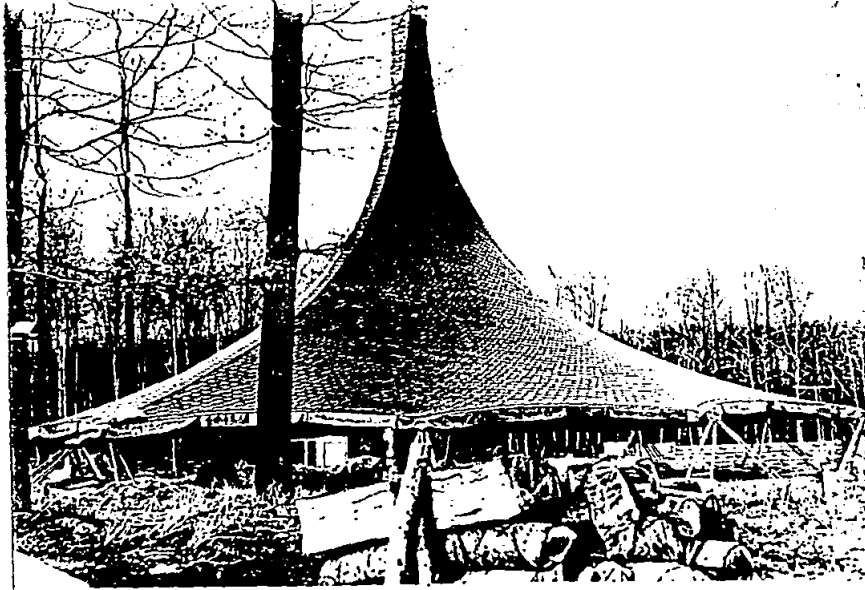
Recubrimiento con teja de asbesto cemento
