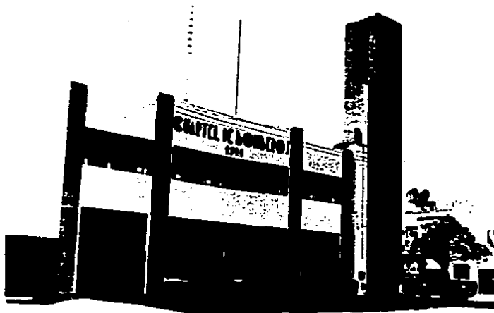
Foto No. 1.- Vista de la Central de Borberos.
