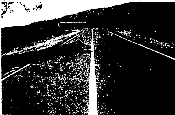
FIGURA No. III-1 CARPETA ASFALTICA DE LA CARRETERA "MORELIA-ZAMORA".
