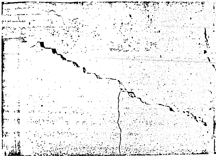
Fotografía 5.6 Falla por cortante en un muro "confinado" sólo por un castillo (en la parte superior derecha de la fotografía) con un estuerzo longitudinal dado por 2 varillas de \phi 3/8".
