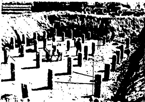
FOTO III. 4 EXCAVACION TERMINADA Y DESCABECE DE PILOTES.
