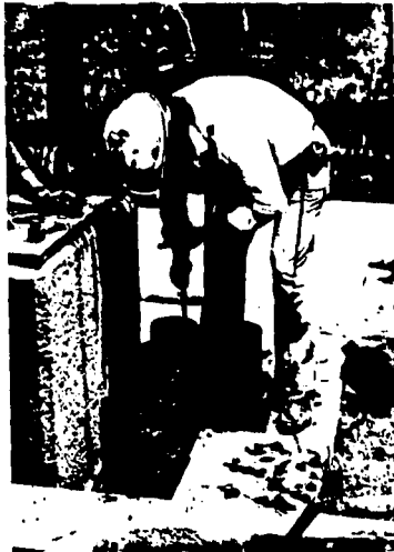
FOTO IV. 4 COMPACTACION DEL CONCRETO EN LOS MOLDES,
