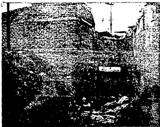
FOTO NUM. 2 - ESTADO GENERAL DEL CAUCE, SE PUEDE OBSERVAR CONSTRUCCIONES SOBRE EL ENCAUZAMIENTO Y DIFERENTES DIMENSIONES EN EL MISMO.
