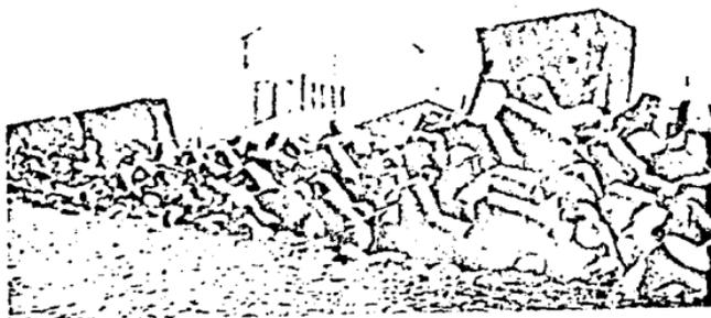
Fig. 10 Vista parcial de los tetrapodos ya colocados.
