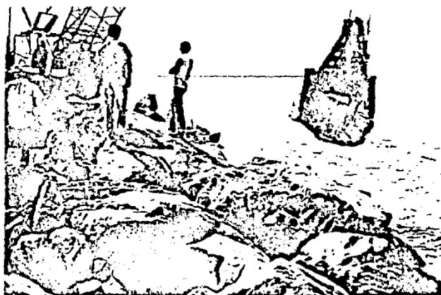
Fig. 23 Seguimiento de la descarga y colocación de la piedra de coraza
