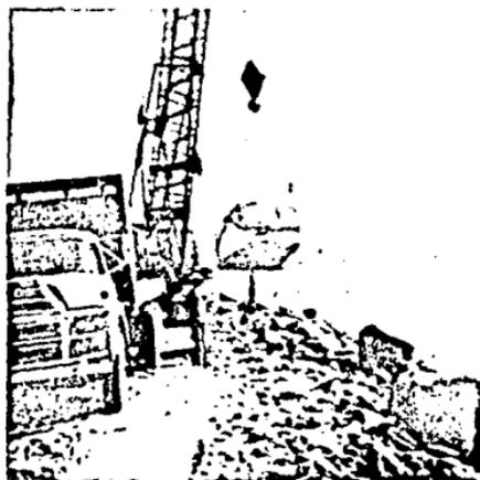
Fig. 25 Colocación del bloque mediante una -- grúa
