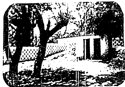
servicios sanitarios "D"
