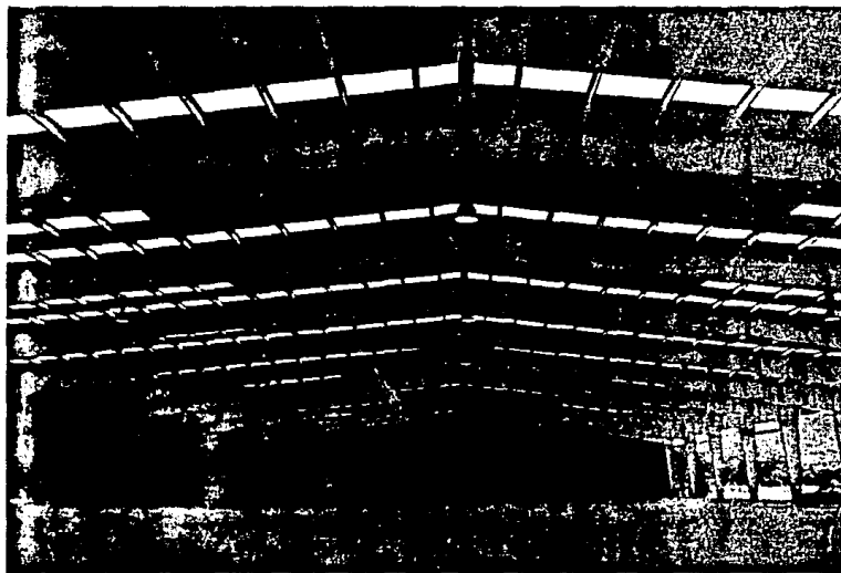
EDIFICIO DE ALMACEN.
