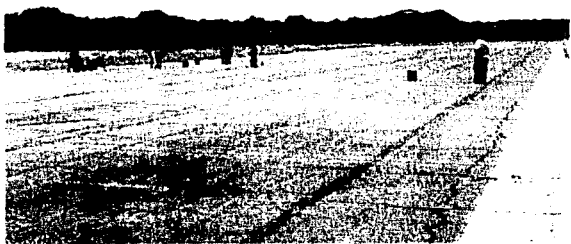
GRIETAS LONGITUDINALES.
