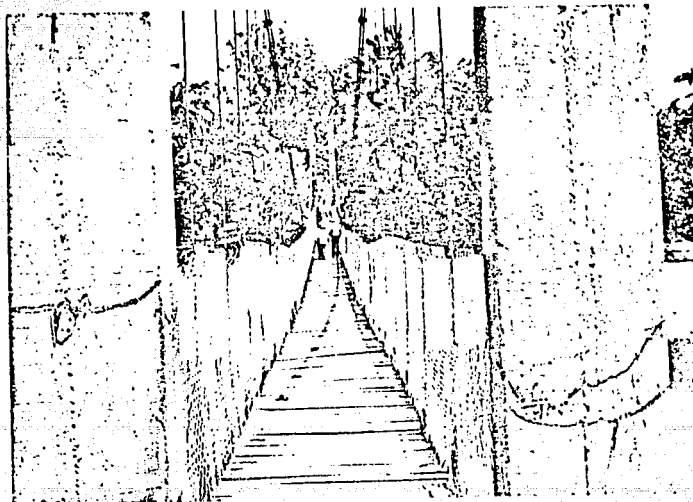
FIG. 4 EN LA PARTE SUPERIOR SE VEN LOS 4 CABLES QUE SUSTENTAN Y A SU VEZ SOPORTAN TANTO A LOS PENDOLONES COMO A LOS TABLONES EN LA PARTE INFERIOR.
