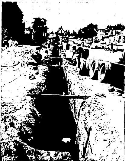
Foto N° 8 Colocación de niveletas para alcantarillado.
