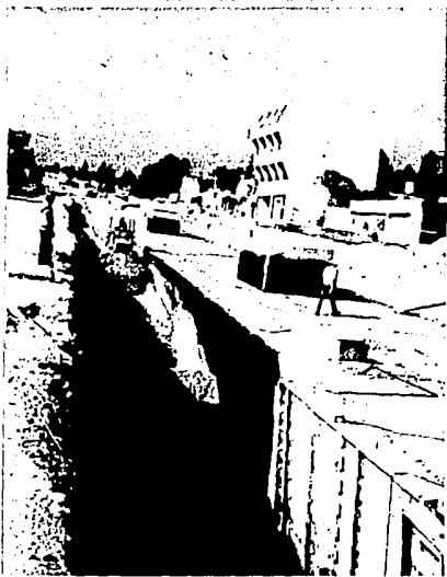
Fotos N° 24 y 25 Relleno y compactación en los - costados del túnel.
