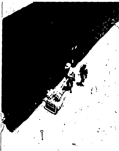
Fotos N° 24 y 25 Relleno y compactación en los - costados del túnel.
