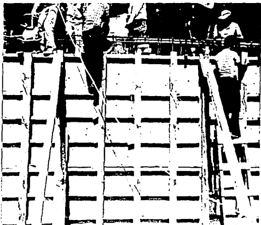
Foto N° 37 Nótese los barros de 2" x 4" que rigidizan la hoja de triplay.
