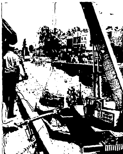
Fotos Nº 15 y 16 Cargando losas con grúa al trailer.
