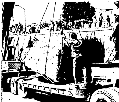
Fotos Nº 15 y 16 Cargando losas con grúa al trailer.
