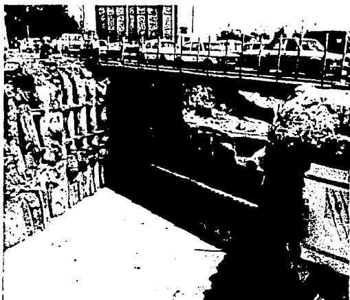
Foto N° 2 Puente vehicular en servicio.
