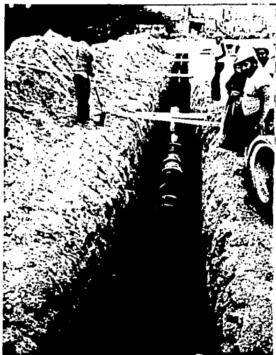
Fotos N° 52 y 53 Tendido de tubería de 24" y 1.83 mts. para aguas negras.
