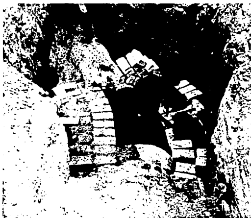
Foto N° 57 Banquetas para un pozo de visita.
