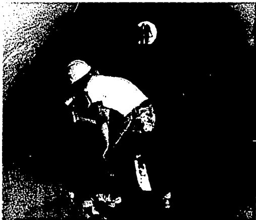
Fotos N° 54 y 55 Colocación de mortero en la - unión de los tubos de 1,83 m.
