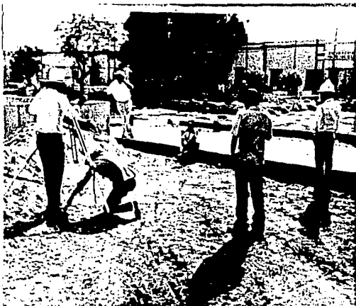
Foto N° 7 Trazo del camellón central en el cruce con la calle Monte Casino,
