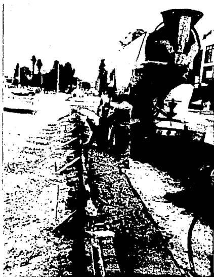
Foto N° 45 Colado de machuelo en pavimento.
