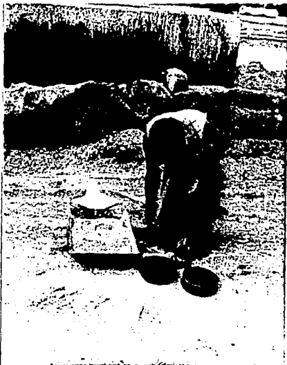
Foto N° 26 Toma de muestra para prueba de compactación en terracerías,
