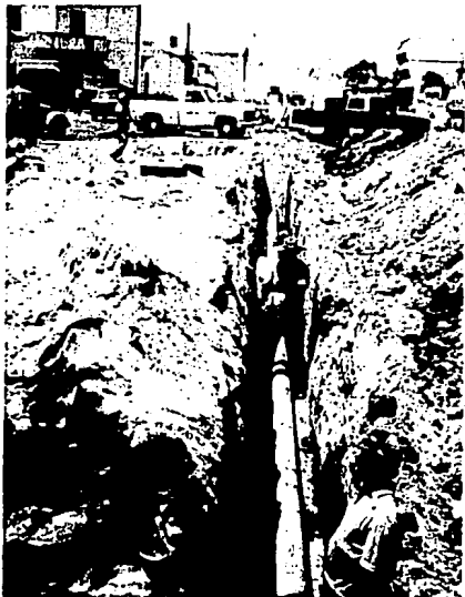
Foto N° 48 Conexión de tubería de agua potable.
