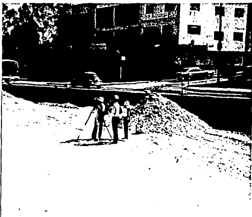
Foto N° 6 Centrando y nivelando el teodolito para el trazo de una curva horizontal.
