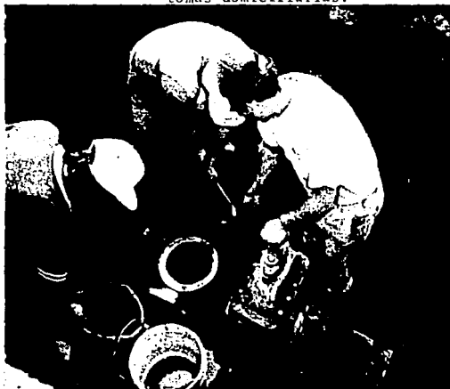
Foto N° 51 Conexión de piezas especiales en un crucero.
