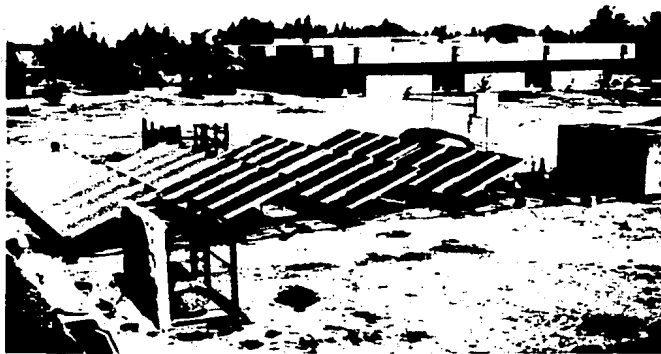
Fig 7.16. Vista general de la instalación
