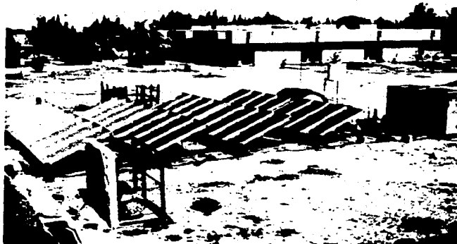
Fig 7.16. Vista general de la instalación
