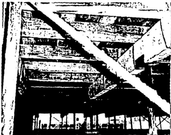
Cimbras de la losa inferior de los nervios colocados con la obra falsa.
