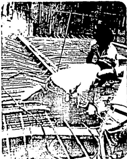
Armado en losa de cimentación colocando el canal de desagüe.
