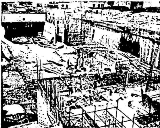
Unión de las losas de cimentación parte norte y sur.
