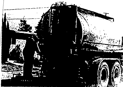
Foto. II-11. Aplicación del riego de hule-asfalto. (ref. # 52).
