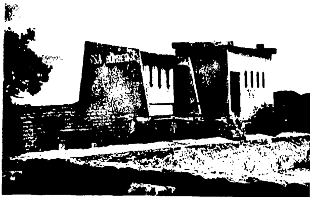
Fotografía 3.3. Vista del cuarto de máquinas.
