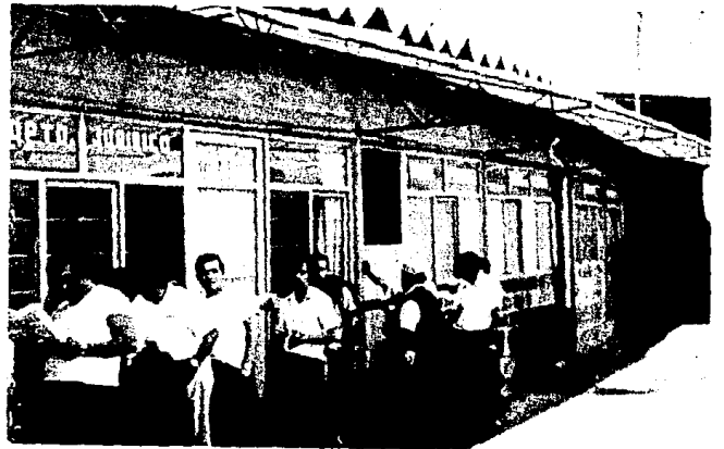
ESTADO ACTUAL DE OFICINAS
