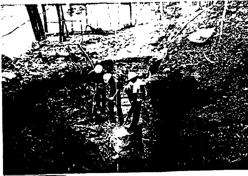
Figura A.4 Excavación con pistolas neumáticas en material tipo III (rocoso) en F.S. 23 (Gimnasio)
