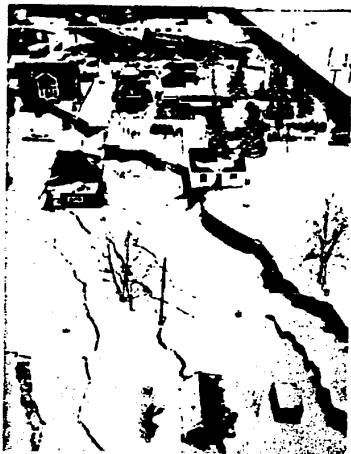
Fig. 2.2 Grietas longitudinales bajo las construcciones (Alaska, 1964).
