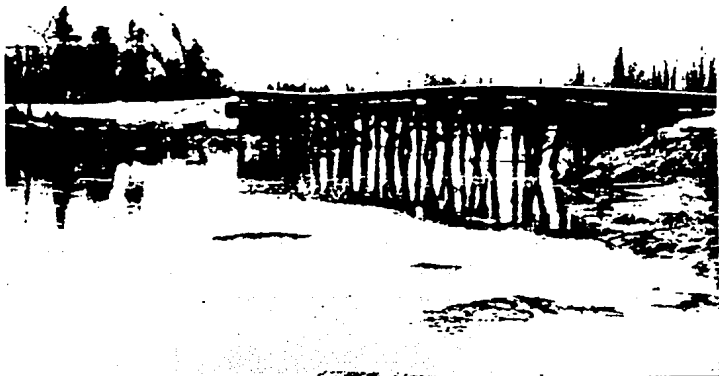
Fig. 2.25. Daños a un puente carretero durante el sismo de Alaska en 1986
