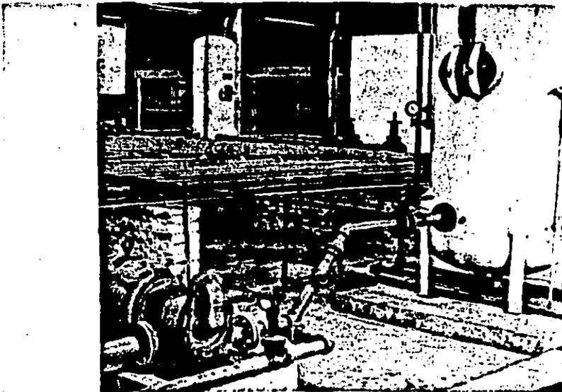
FIGURA 3.2 Bomba centrífuga y tanque aguas arriba
