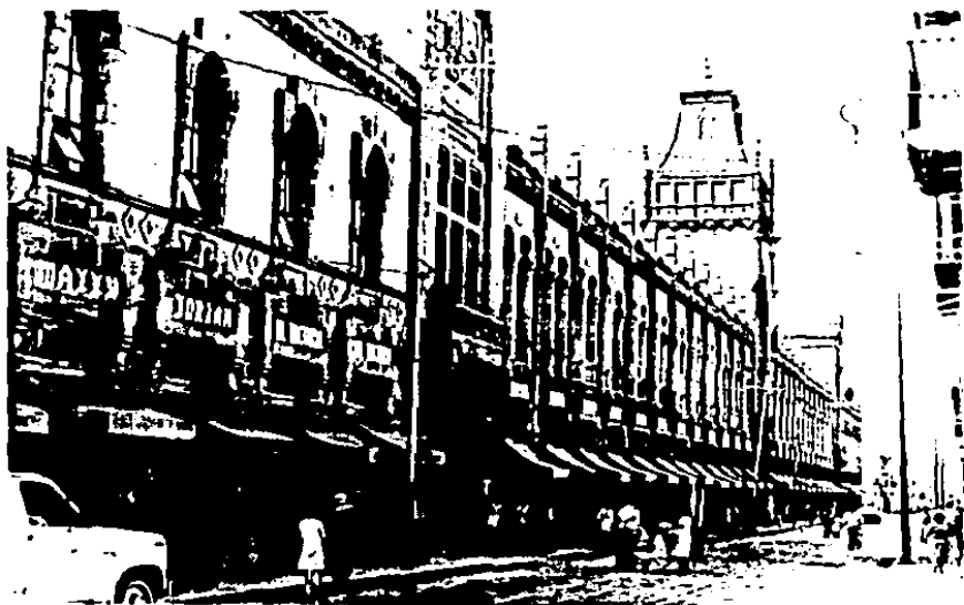
Fachada sobre la 3 Norte.
