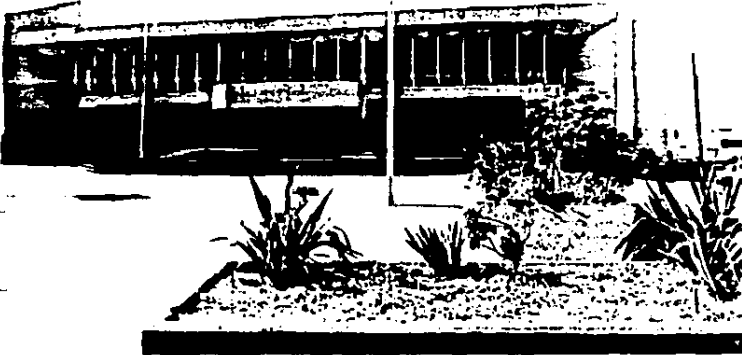
Edificio de la Dirección de Tránsito, en La Paz.
