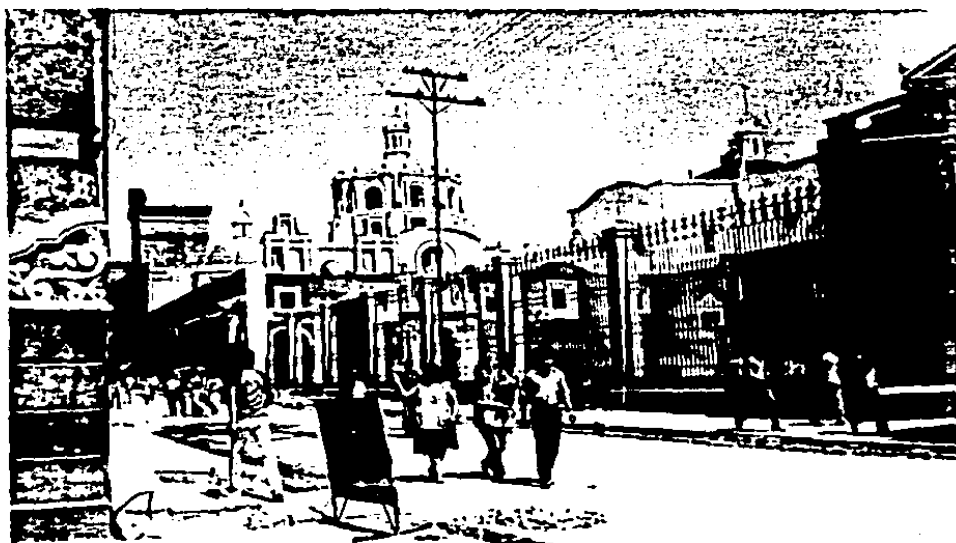
Atrio de Santo Domingo ya remodelado.
