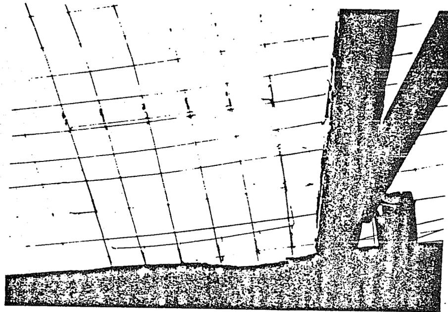
DETALLE DEL ARMADO DEL GRAN GALPON SE OBSERVA LA PREPARACION PARA LA LUCARNA.
