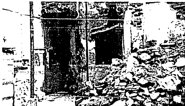
DERRUMBE POR SISMO.
