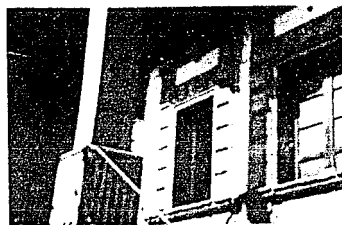
LISTA 9. DETALLE DE LA FACHADA INTERIOR.
