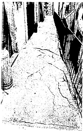
Afectaciones en el pasillo
