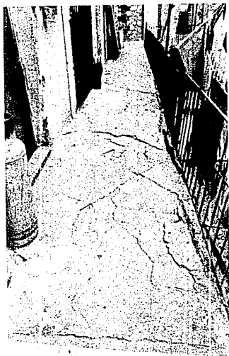
Afectaciones en el pasillo
