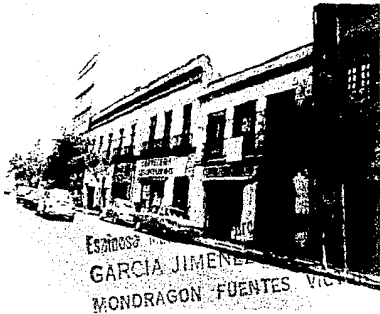
Calle de Mina
