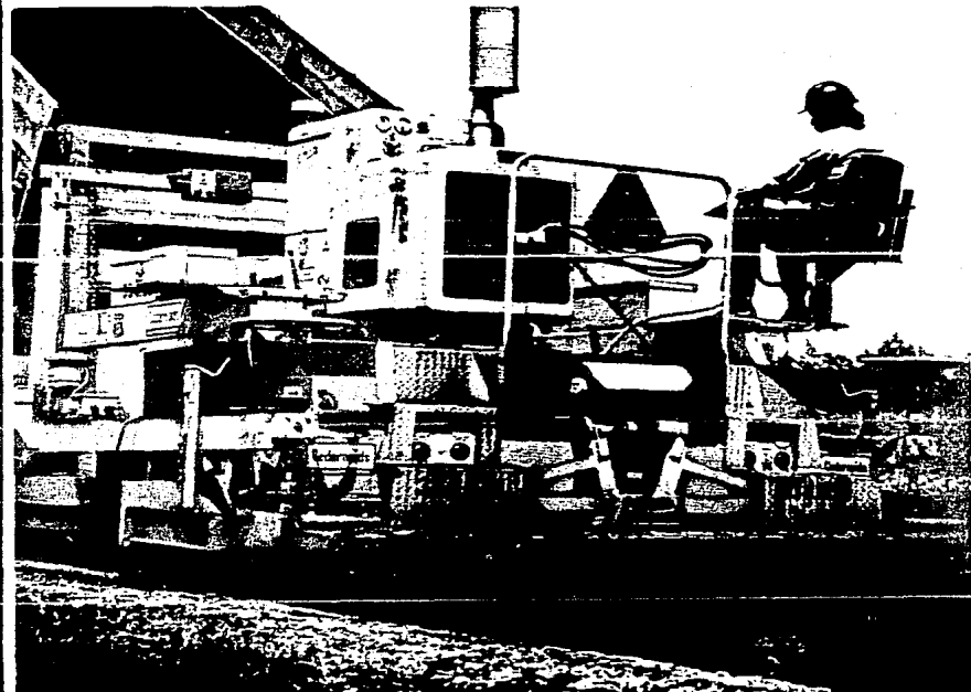
MAQUINA PAVIMENTADORA EN FUNCIONAMIENTO
