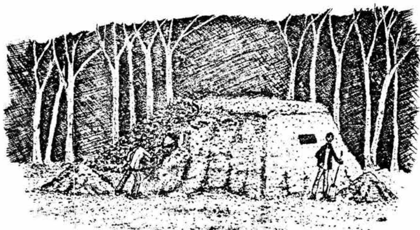
Fig. 3 Última fase de construcción del horno consistente en el cubrimiento de la hojarasca por tierra.
