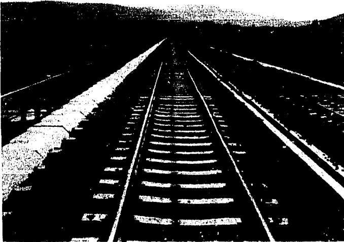
Doble vía elástica, tramo México-Querétaro (viaducto).
