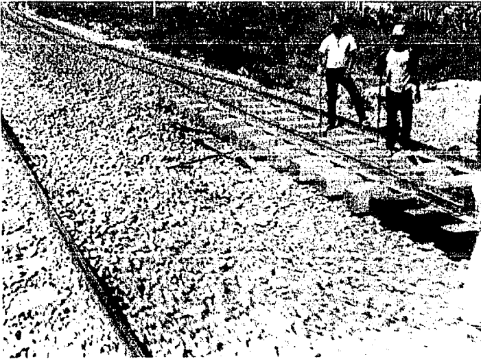
Nivelación de vía elástica (tramo México-Querétaro).
