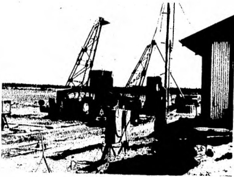
PROCESO DE EXCAVACION PARA LAS PILAS DEL -- MUELLE INDUSTRIAL.
