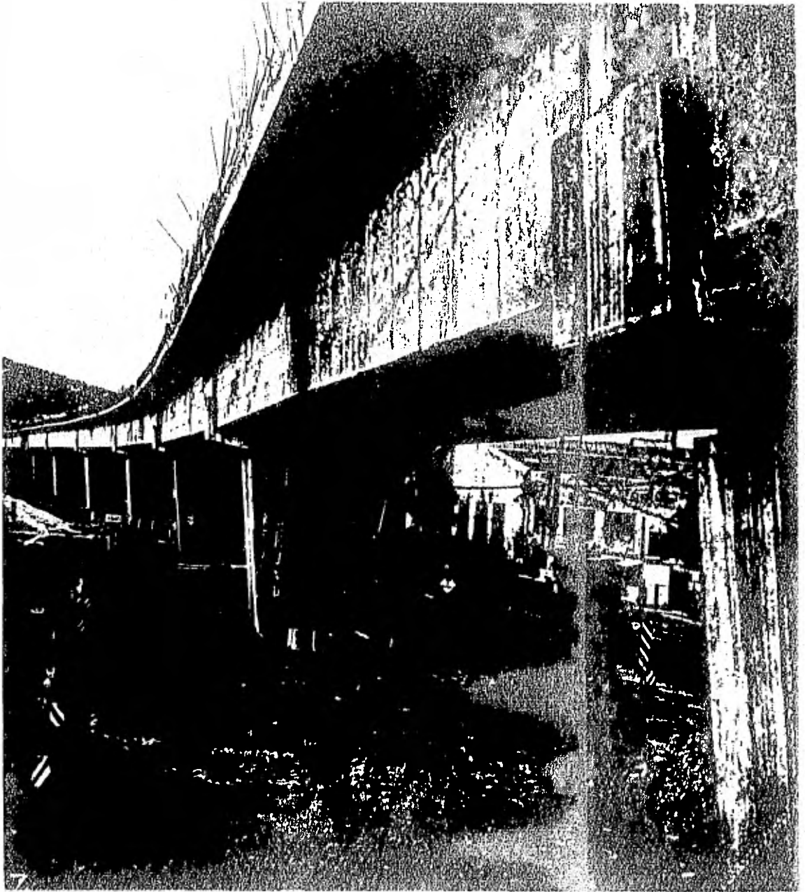
CONSTRUCCIÓN DEL NUEVO TRAMO DE METRO ELLEVADO EN UN ESPACIO
