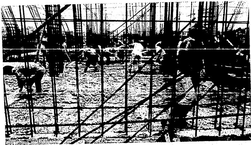
En esta fotografía ya se puede apreciar el armado de las columnas, así como el armado que se deja como preparación para más adelante colar lo que serán los muros del Bañín de agua fría.
