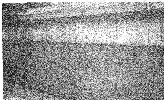
Pared terminada bajo la cimbra deslizante.
