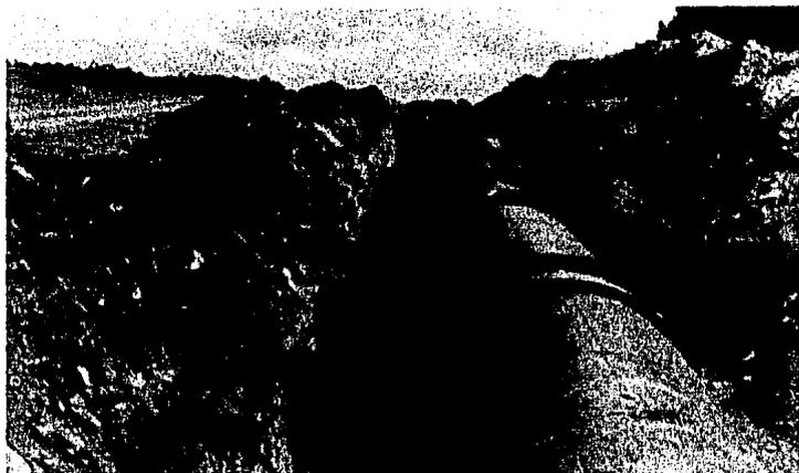
*El acostillado, con material homogéneo y compactado*
