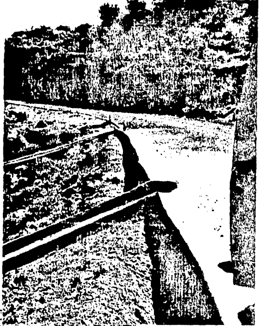
Fig. ( h ).- Lavadero de concreto, en correcto funcionamiento.
