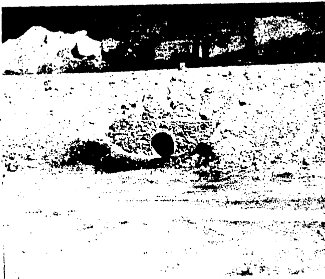
Fig. ( r ).- ins- tala o n de una al- cantarilla rí g ida de tubo de concre- to.
