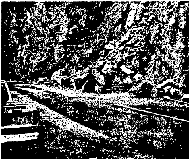
Foto ( e ).- Derrumbe de rocas en la carretera de Cd. Altamirano -Zihuatanejo.
