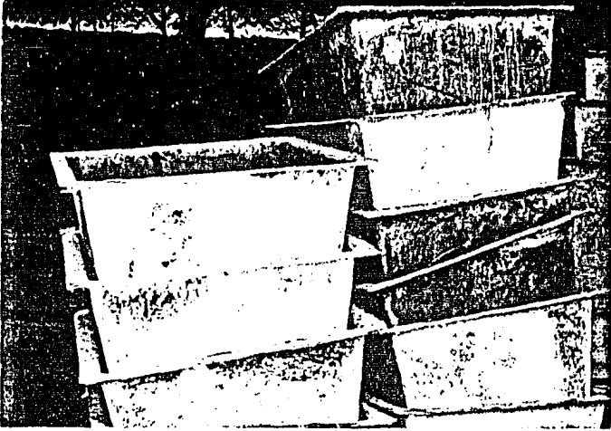
Casetones de fibra de vidrio para el aligeramiento de la losa.
