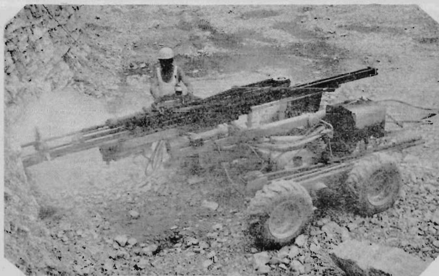
PERFORADORA DE VAGONETA MONTADA SOBRE LLANTAS
