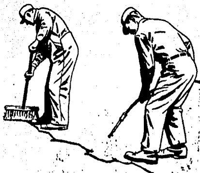
LIJANDO LA GRIETA CON ESCOBA Y AIRE.
