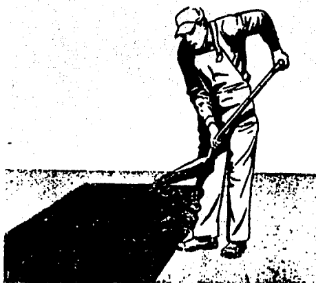
APLICANDO AGREGADO DE CUBIERTA.
