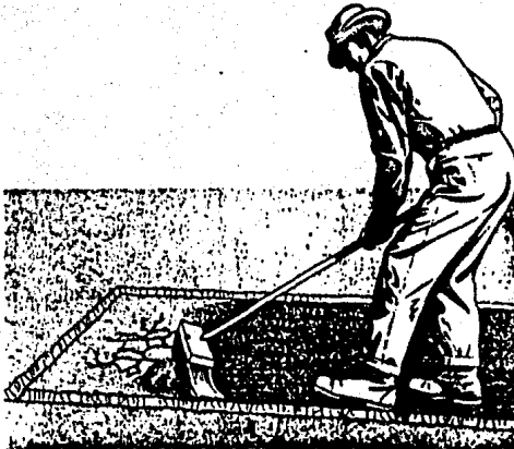
EXTENDIENDO MEZCLA DE CONCRETO ASFALTICO EN CRISTAS DE PIEL DE COCODRITO.
