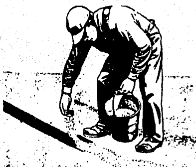
ESPARCIENDO ARENA SECA EN LA SUPERFICIE.
