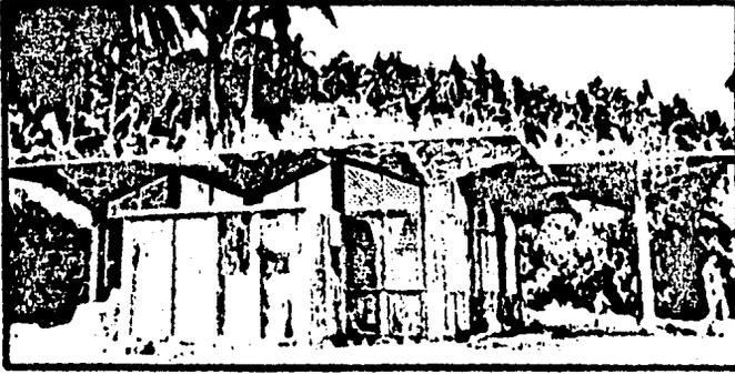
Fig. 5.5 Residencia construida con elementos modulares - de ferrocemento para techo, en Filipinas.
