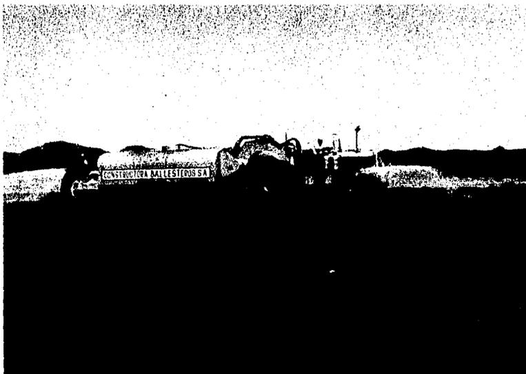
Vista de una pipa aplicando agua al material para conformar y compactar capa de sub-base.
