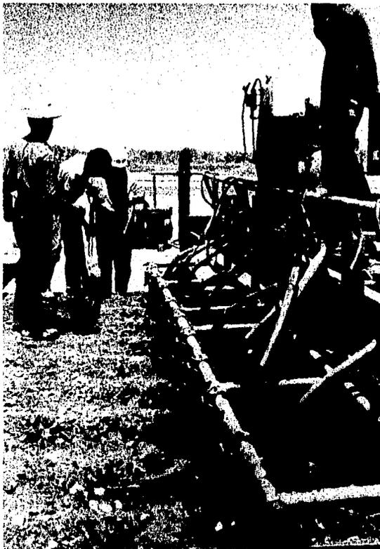
Aspecto de un tren de vibradores, debidamente distribuidos para lograr un vibrado perfecto
