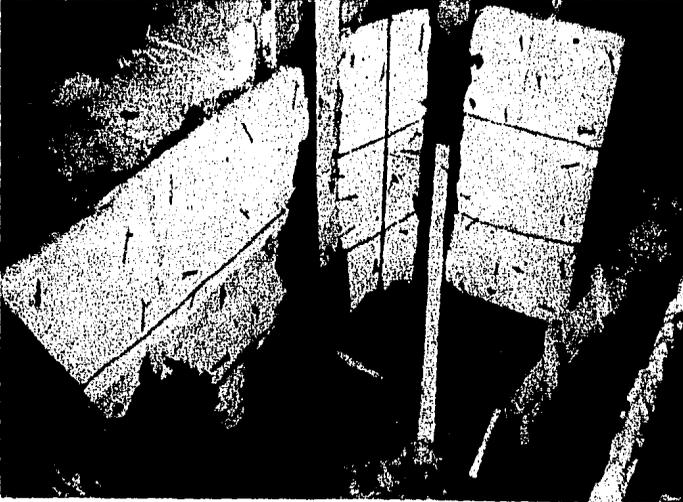
ñ) En la construcción de la losa, se arma un emparrillado igual al especificado en el Pozo GI de concreto.
