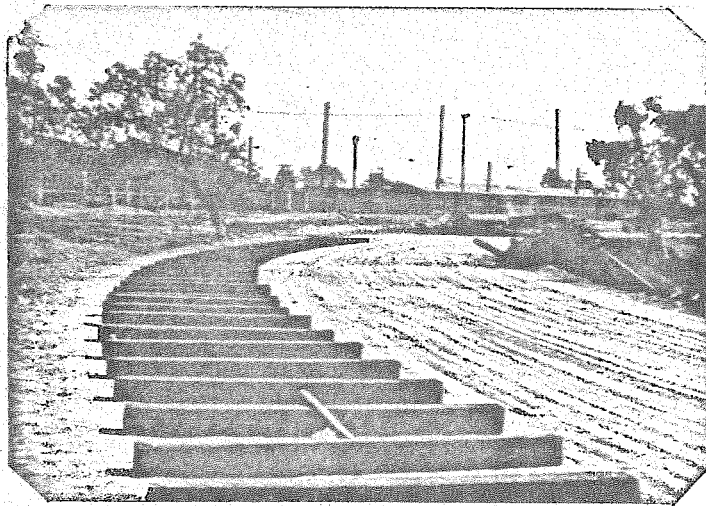
Tendido de durmientes
