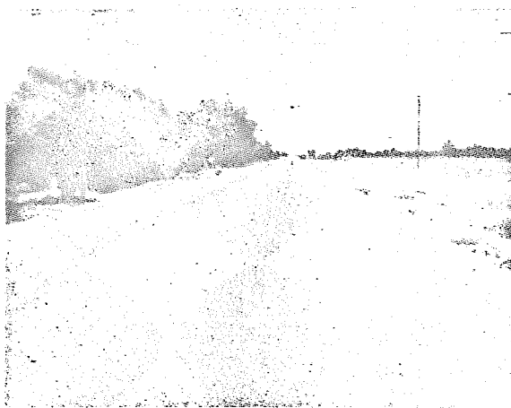
PROTECCION DE UN CAMINO CONTRA INVASION DE ARENA PROVOCADA POR EL VIENTO, POR MEDIO DE ARBOLES. CARRETERA BATAQUES - MURGUIA. ( ESTADO DE BAJA CALIFORNIA ).
