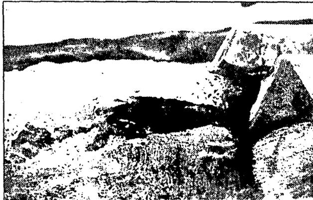
Fotografía No. 28 .- Lanzamiento del flujo por la cubeta deflectora. Solución adoptada. Parte Baja de la Estructura.
