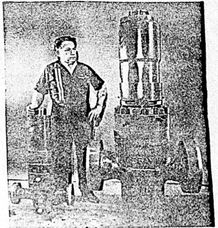
FIG. 33.- TAMAÑO RELATIVO DE DOS VALVULAS DE 2 PG. y 6 PG., DE LA MISMA PRE- SION 350KG./cm 2 .
